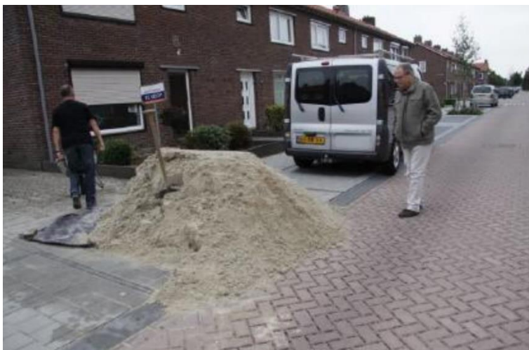
Figuur 6-2: Vervuiling van de verharding door storten van zand
